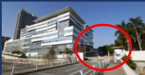
HKSI Main Entrance 香港體育學院正門
